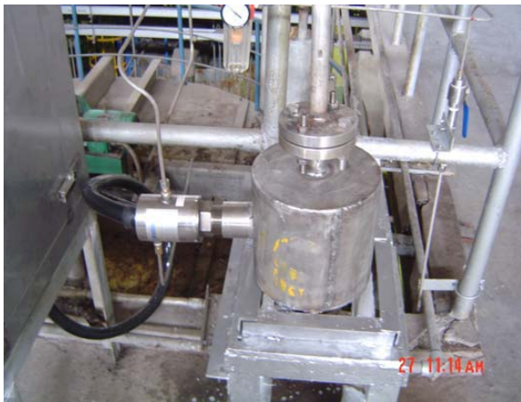
※VA-100 小型反应釜安装
